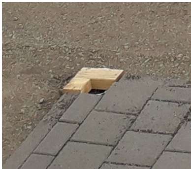
Schalung Torpfosten-Fundament
