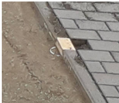
Schalung Längsposten-Fundament
