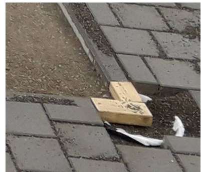
Schalung Eckpfosten-Fundament
