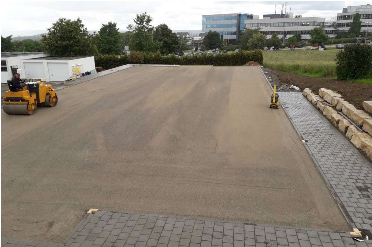
Schottererschicht eben und gleichmäßig tritt- und scherfest verdichtet
