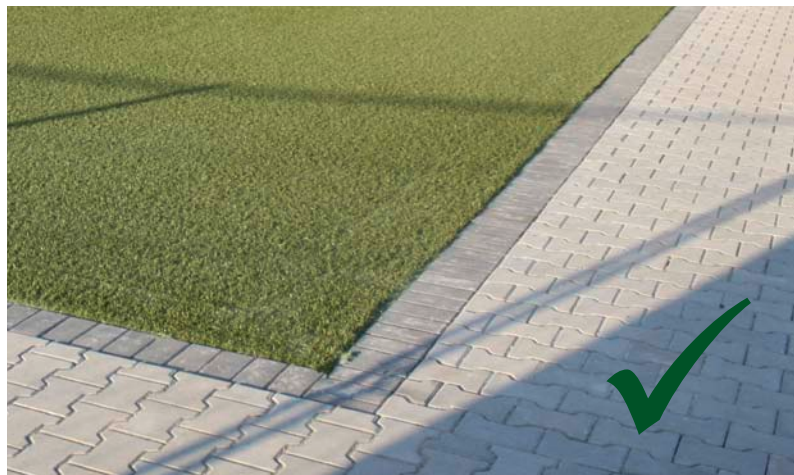
Umlaufende Pflasterung ebenflächig.
