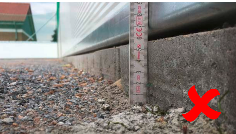
SO NICHT: Einbauhöhe zu hoch / niedrig.
