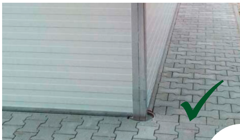
Fundamente gemäß Fundamentplan platziert.
