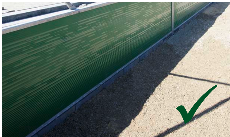
Randstein richtig platziert (innen bündig mit Bande).
