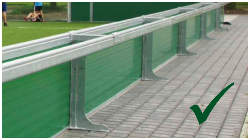
Randstein und Pflaster eben, damit Füße plan aufstehen.
