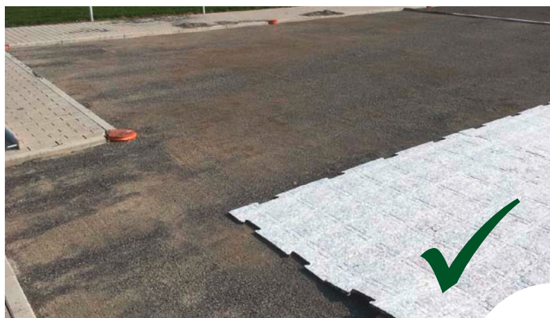
Schotter geebnet und tritt-/scherfest verdichtet.
