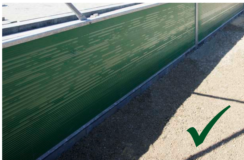
Randstein richtig platziert (innen bündig mit Bande).
