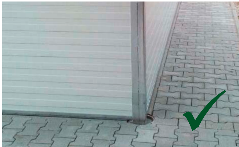
Fundamente / Leerrohre gemäß Fundamentplan platziert.
