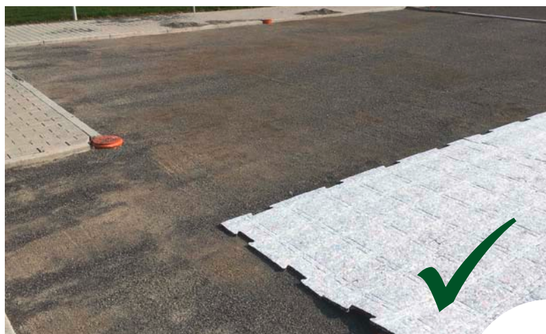
Schotter geebnet und tritt-/scherfest verdichtet.
