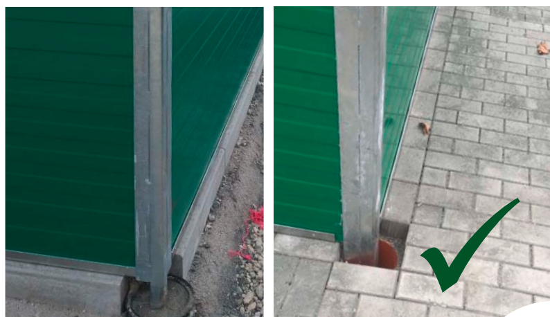
Randstein bis an das Leerrohr heran gebaut. Nach Verguss kann außen herangepflastert werden.
