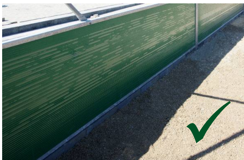
Randstein richtig platziert (innen bündig mit Bande).
