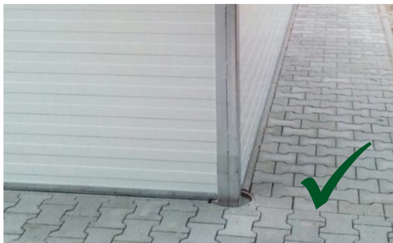
Fundamente / Leerrohre gemäß Fundamentplan platziert.
