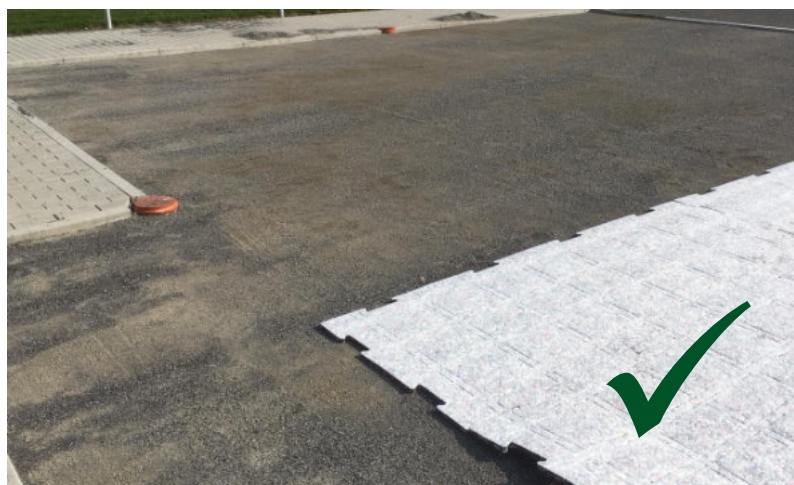
Schotter geebnet und tritt-/scherfest verdichtet.
