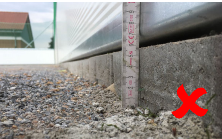
SO NICHT: Einbauhöhe zu hoch / niedrig.
