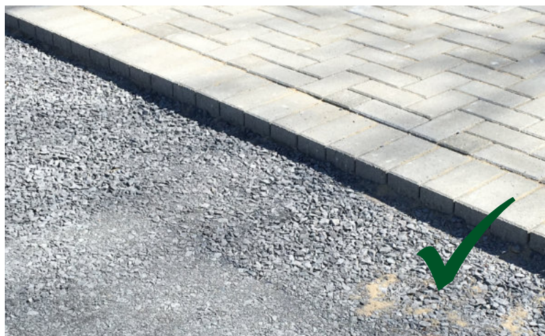
Einbauhöhe gleichmäßig, gemäß Vorgabe.
